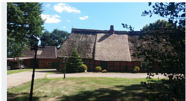
Nordseite mit Nebengebäude
